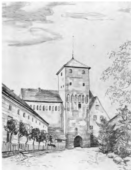
Ryc. 1. I. Meyer-Pyritz, Darłowo, Zamek Książęcy (Sanier 1939: 65)
